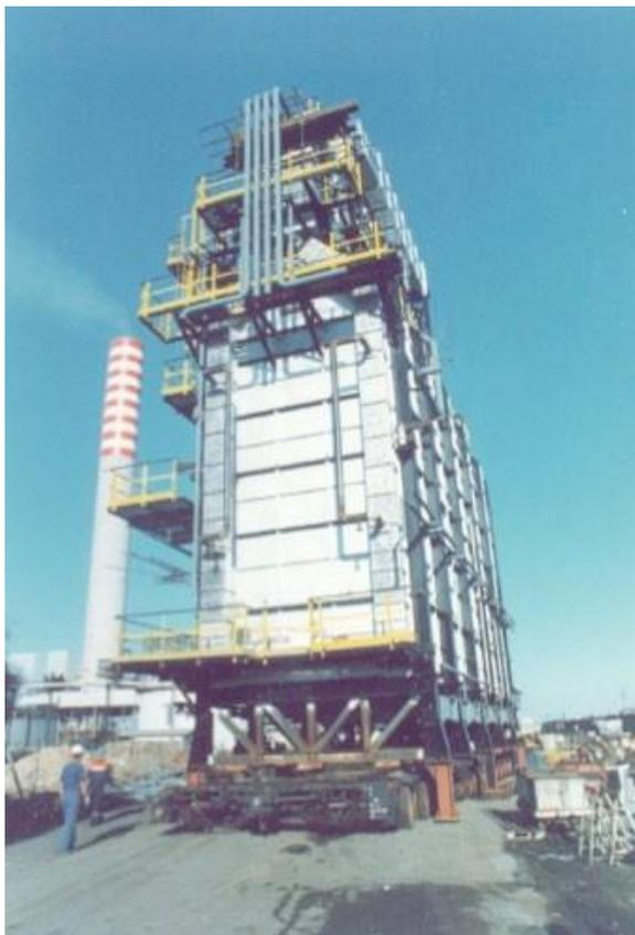
Для легкого перемещения комплектных печей мы обычно используем самоходные прицепы. В нашем проекте конструкций учитываются условия нагрузки, имеющиеся не только в ходе эксплуатации, но в частности на всех фазах транспортировки, подъема и монтажа.
